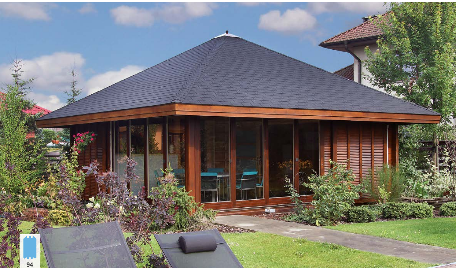
Ombre fenêtre placé ultérieurement par le client
