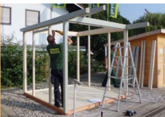
Montage de l'ossature autoportante
