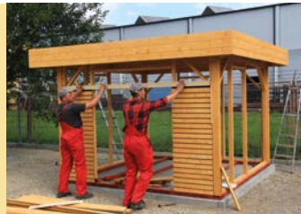
Montage du coffrage en losange
