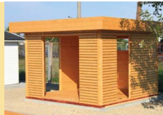
Coffrage de toit et de mur
